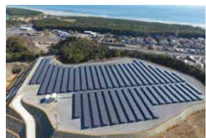
日向市財光寺太陽光発電所 出力1,105.58kW
