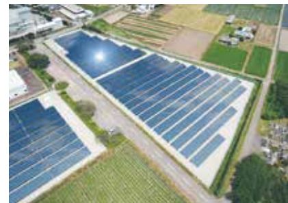
川南C地区 1.3ha 出力871kW
