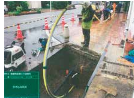
非開削工法（パイプスプリッター工法）
