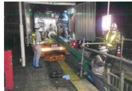
更生修理工法
