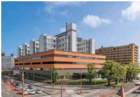
県立宮崎病院様 建物外観
