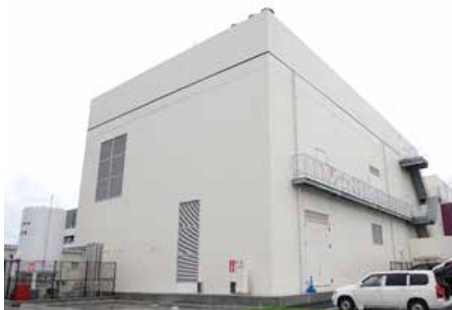
宮崎市郡医師会病院様 エネルギーセンターの建物外観
