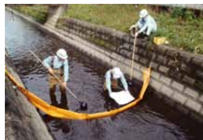
オイルフェンスで油の拡散を防止
