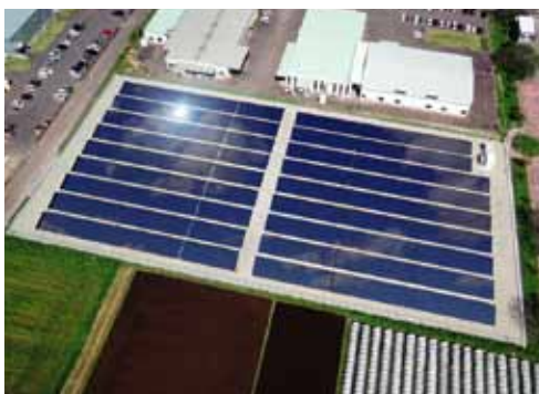
B地区 0.9ha 出力636kw
