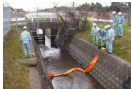
オイルフェンスで油の拡散を防止
